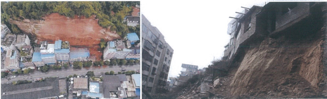
图 D. 1-9、图 D. 1-10 临崖危岩崩塌
