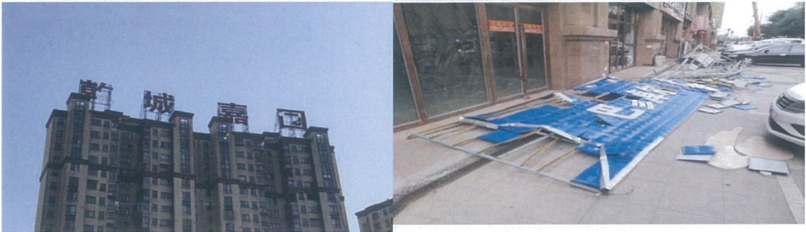
图 D. 4-3 部分掉落的广告字图、D. 4-4 掉落在地的广告牌
